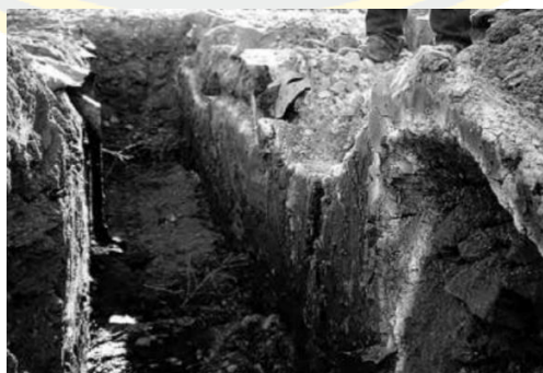
ภาพที่ 4 การเสียรูปของชั้นพื้นคั่นทางแบบก้าวหน้า (Progressive Shear Failure)
