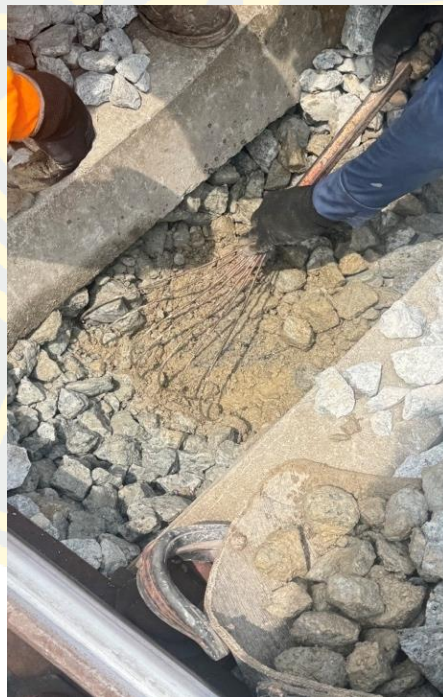
ภาพที่ 22 ลักษณะหินโรยทางที่มีการปนเปื้อนของวัสดุละเอียด
