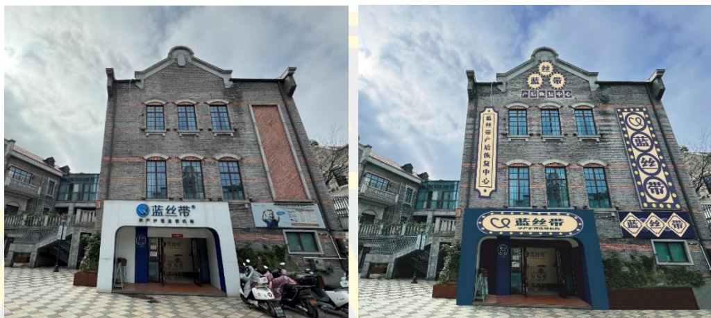
ภาพที่ 5-27 สถาปัตยกรรมหมายเลข C2 ก่อนและหลังการปรับปรุงการออกแบบ (Y.TIAN, 2024)
