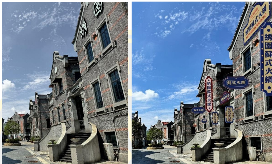
ภาพที่ 5-31 สถาปัตยกรรมหมายเลข C6 ก่อนและหลังการปรับปรุงการออกแบบ (Y.TIAN, 2024)
