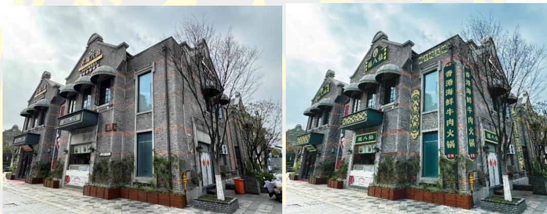
ภาพที่ 5-29 สถาปัตยกรรมหมายเลข C4 ก่อนและหลังการปรับปรุงการออกแบบ (Y.TIAN, 2024)
