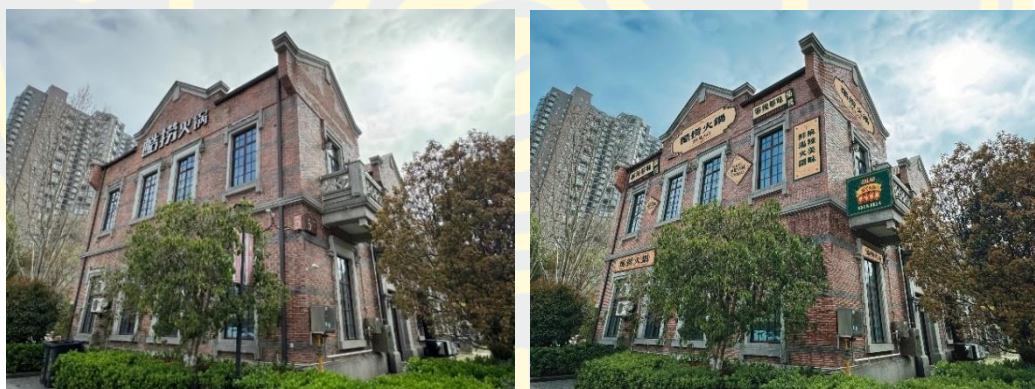
ภาพที่ 5-28 สถาปัตยกรรมหมายเลข C3 ก่อนและหลังการปรับปรุงการออกแบบ (Y.TIAN, 2024)
