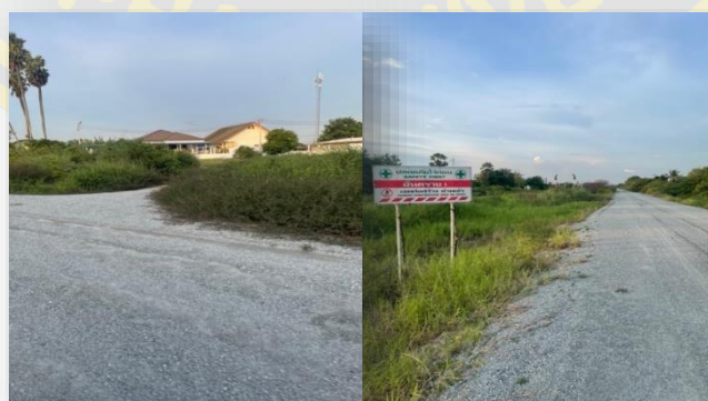
ภาพที่ 7 พื้นที่ของชุมชนตำบลหนองช้างคอกเมื่อเริ่มมีการเข้ามาดำเนินการของโครงการก่อสร้างเส้นทางรถไฟฟ้าความเร็วสูง
