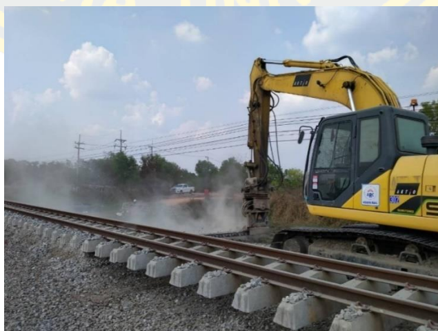
ภาพที่ 4-9 ปาดชั้นหินโรยทางบริเวณใต้หมอนรองราง
