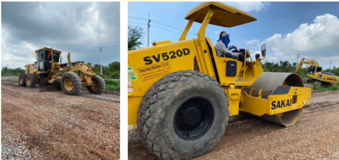
ภาพที่ 4-4 การปรับปรุงชั้นพื้นทาง
