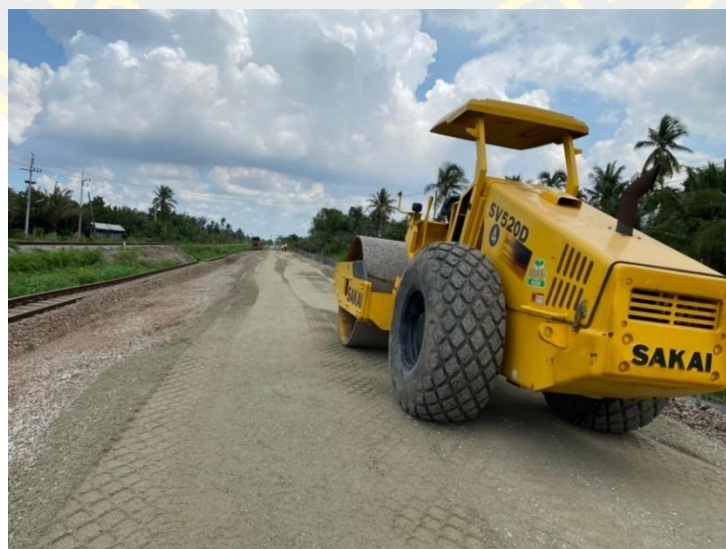
ภาพที่ 4-5 การก่อสร้างชั้นรองหินโรยทาง
