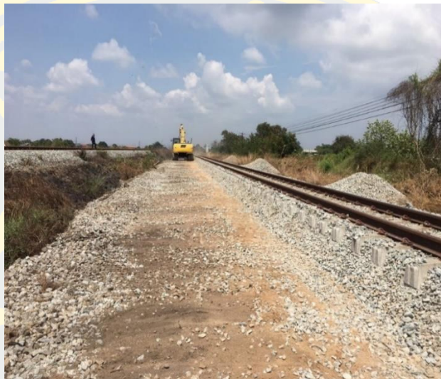
ภาพที่ 4-8 ตัดดินบ่าทางด้านข้างชั้นหินโรยทาง
