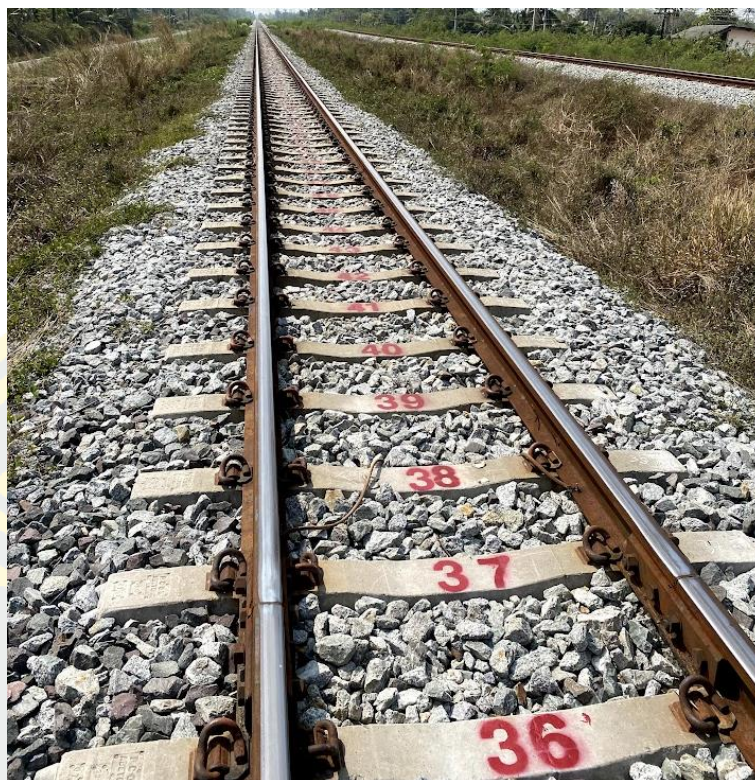
ภาพที่ 3-2 ตัวอย่างการบ่มเบอร์หมอนรองราง
