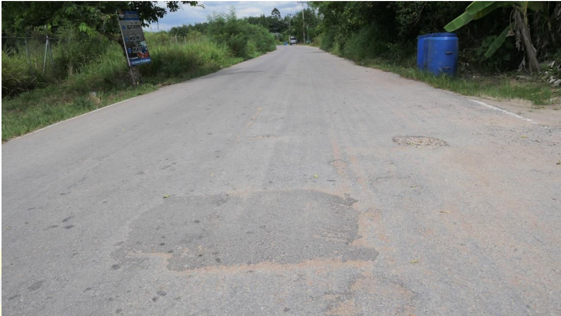
ภาพที่ 16 ถนนบริเวณรอบพื้นที่ดำเนินโครงการ (1)
